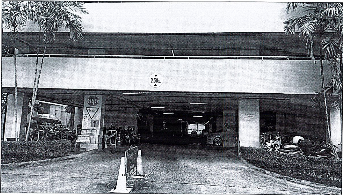
ทางเข้าอาคารงามดูพลี ฝั่งอาคารโรงไฟฟ้า
