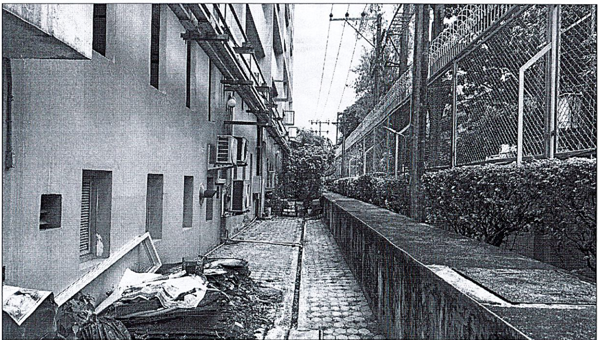
ทางเดินไปยัง Outdoor Unit ฟังอาคารโรงไฟฟ้า
