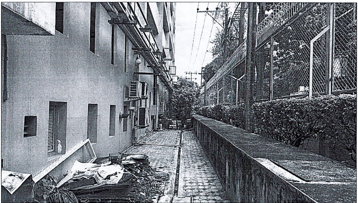
ทางเดินไปยัง Outdoor Unit ฝั่งอาคารโรงไฟฟ้า
