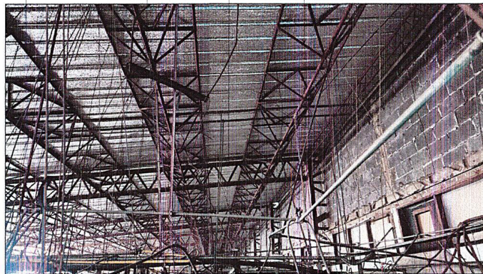
ขัดทำความสะอาดสนิม และทาสีน้ำมันตามกรรมวิธีผู้ผลิต ที่ a-e ของแป ปลายันหัน ทิวทั้งโครงสร้างหลังคา
