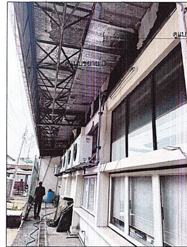
รื้อถอนหลังคา Metal Sheet พร้อมฉนวนกันความร้อนที่หลุดล่อน เดิม
