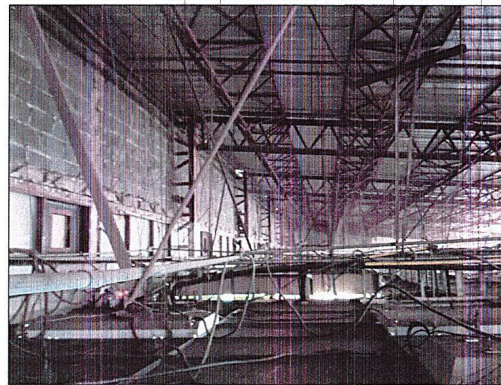
..... สะอาดสนิม และทาสีน้ำมันตามกรรมวิธีผู้ผลิต ที่ a-e ของแป ปลายันหัน ทิวทั้งโครงสร้างหลังคา
