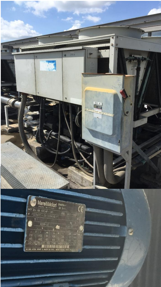
รูปที่ ๒ มอเตอร์พัดลมคอมpressor Chiller5-6 คาบฟ้าชั้น ๗ Support Building (SPB)
