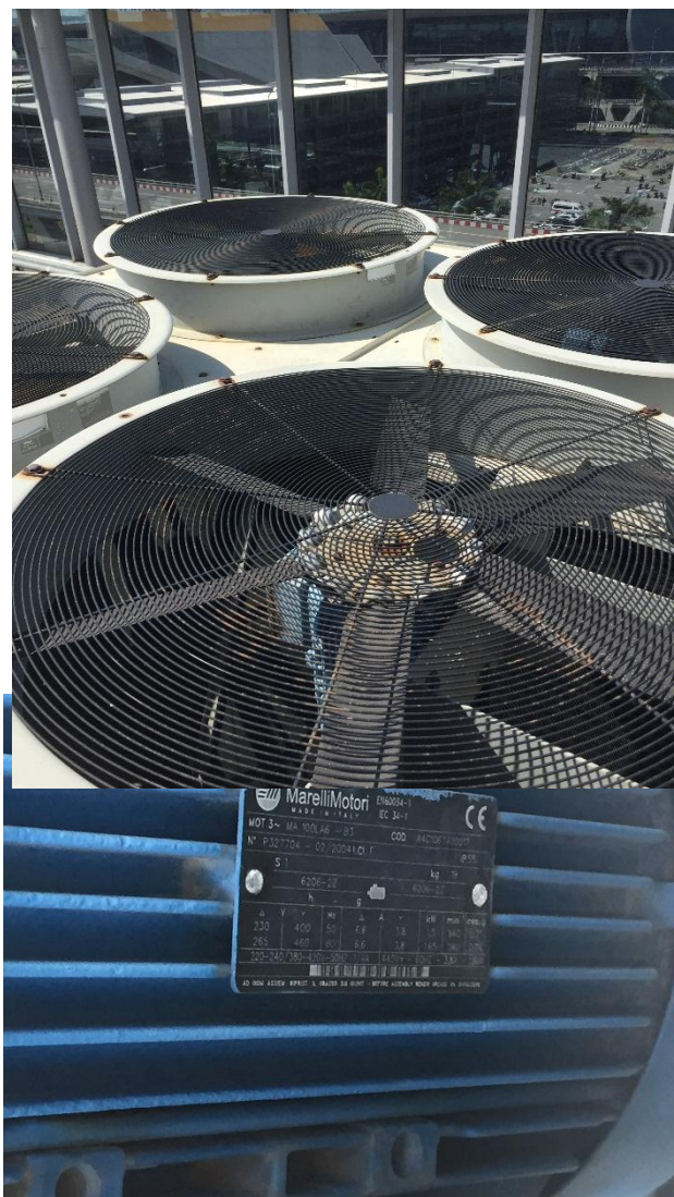
รูปที่ ๒ มอเตอร์พัดลมคอมpressor Chiller5-6 คาบฟ้าชั้น ๗ Support Building (SPB)
