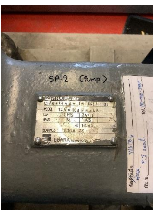
รูปที่ ๔ มอเตอร์ปั๊มน้ำ, ปั๊มน้ำเย็น ของเครื่องปรับอากาศชนิดรวมศูนย์ระบบทำความร้อนด้วยอากาศ (Air Cool Chiller) Chiller1-6 คาดฟ้าชั้น ๓ Support Building (SPB)
