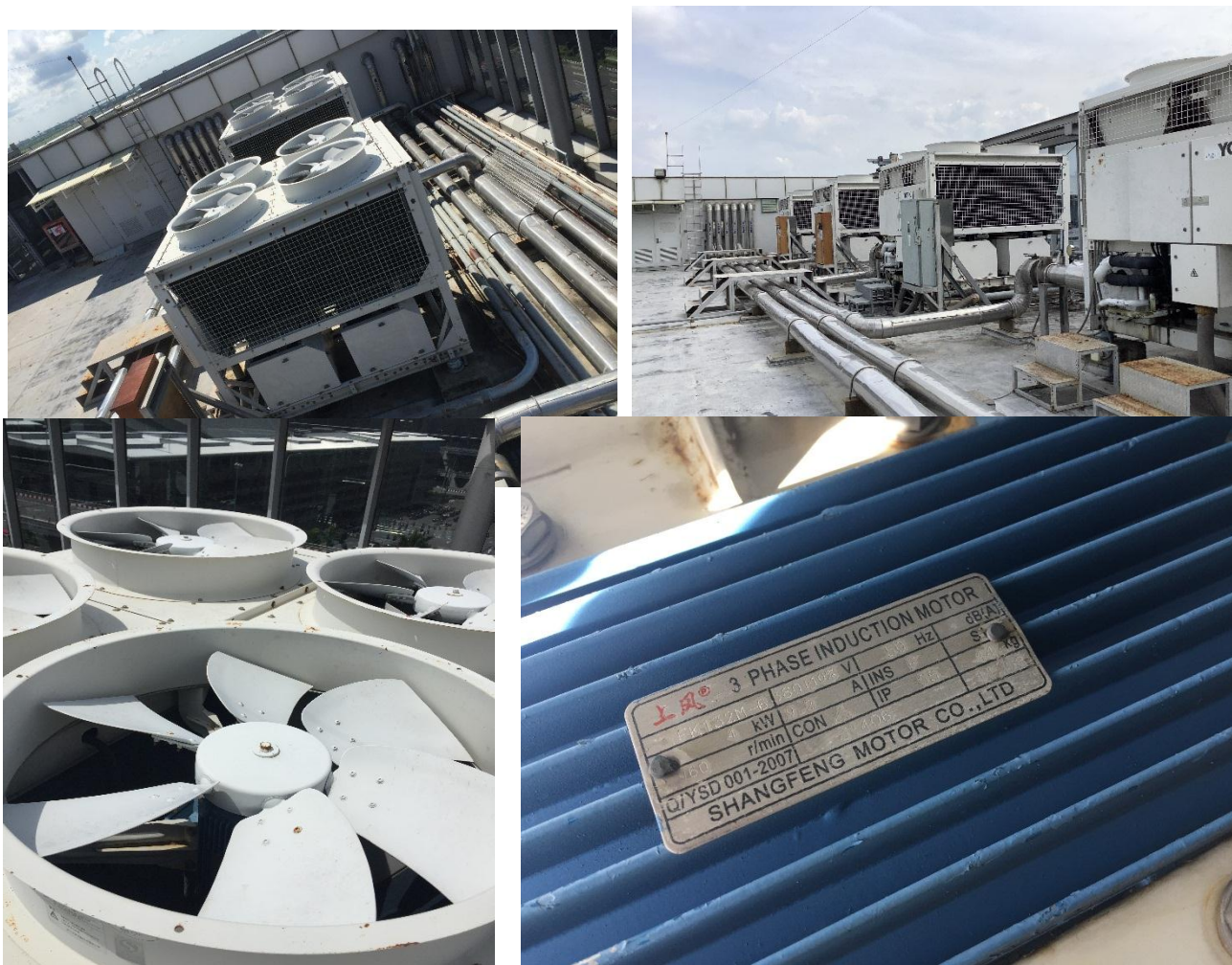
รูปที่ ๑ มอเตอร์พัดลมคอร์ยร้อน Chiller1-4 คาดฟ้าชั้น ๗ Support Building (SPB)
