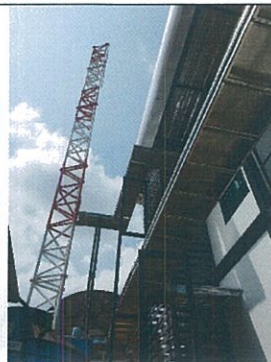
รูปที่ ๕ แนวติดตั้ง RF Cable TX Antenna จากยอดเสา Tower และติดตั้ง Grounding Kit
