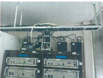
รูปที่ ๗ ๘ และ ๙ ติดตั้ง Cable Ladder ภายในยาวประมาณ ๑๐ เมตร
