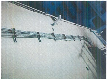
รูปที่ ๔ ๕ และรูปที่ ๖ แสดง cable Ladder ข้างอาคารเดิม รื้อถอนและติดตั้ง cable Ladder ใหม่
