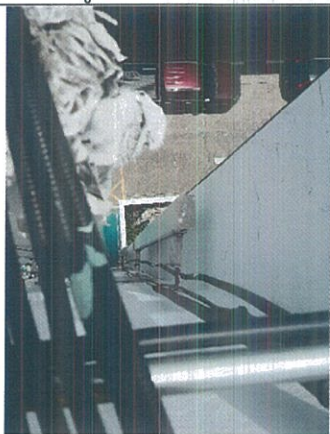
รูปที่ ๗ แสดงติดตั้งเหล็กฉากพร้อมพุกยึดติดผนัง เพื่อจับ Feeder Clamp ข้างอาคารทุก ๘๐ ซม.
