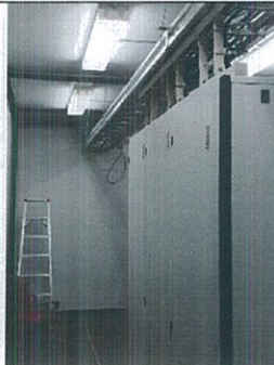
รูปที่ ๖ และ ๗ แนวติดตั้ง RF Cable มาห้องอุปกรณ์ที่ชั้น ๑
