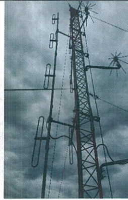
รูปที่ ๖ และรูปที่ ๗ แนว Cable Ladder ภายใน เพลี่ยนไหมในส่วนที่เป็นอลูมิเนียม ยาวประมาณ ๑๐ เมตร รูปที่ ๘ เสาสูง ๙ เมตร ต้องเปลี่ยน Guyed Wire
