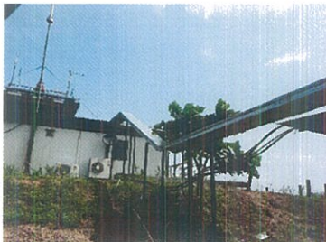
รูปที่ ๓ และรูปที่ ๔ แนวติดตั้ง RF Cable RX Antenna
