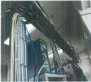
รูปที่ ๖ และรูปที่ ๗ แนว Cable Ladder ภายใน เพลี่ยนไหมในส่วนที่เป็นอลูมิเนียม ยาวประมาณ ๑๐ เมตร รูปที่ ๘ เสาสูง ๙ เมตร ต้องเปลี่ยน Guyed Wire
