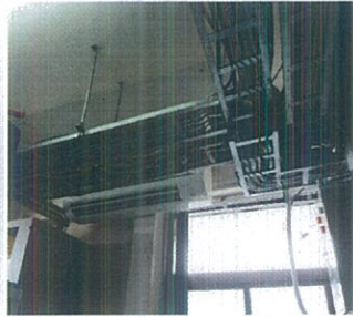
รูปที่ ๖ และรูปที่ ๗ แนว Cable Ladder ภายใน เพลี่ยนไหมในส่วนที่เป็นอลูมิเนียม ยาวประมาณ ๑๐ เมตร รูปที่ ๘ เสาสูง ๙ เมตร ต้องเปลี่ยน Guyed Wire
