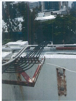
รูปที่ ๔ ๕ และรูปที่ ๖ แสดง cable Ladder ข้างอาคารเดิม รื้อถอนและติดตั้ง cable Ladder ใหม่
