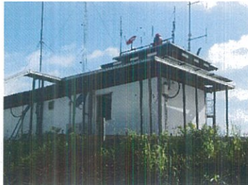
รูปที่ ๓ และรูปที่ ๔ แนวติดตั้ง RF Cable RX Antenna
