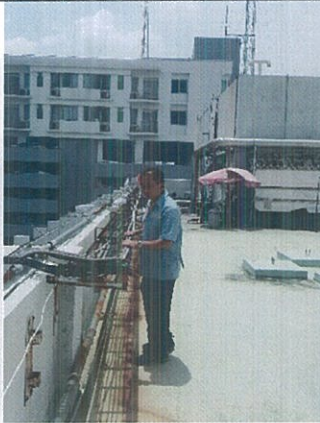
รูปที่ ๔ ๕ และรูปที่ ๖ แสดง cable Ladder ข้างอาคารเดิม รื้อถอนและติดตั้ง cable Ladder ใหม่
