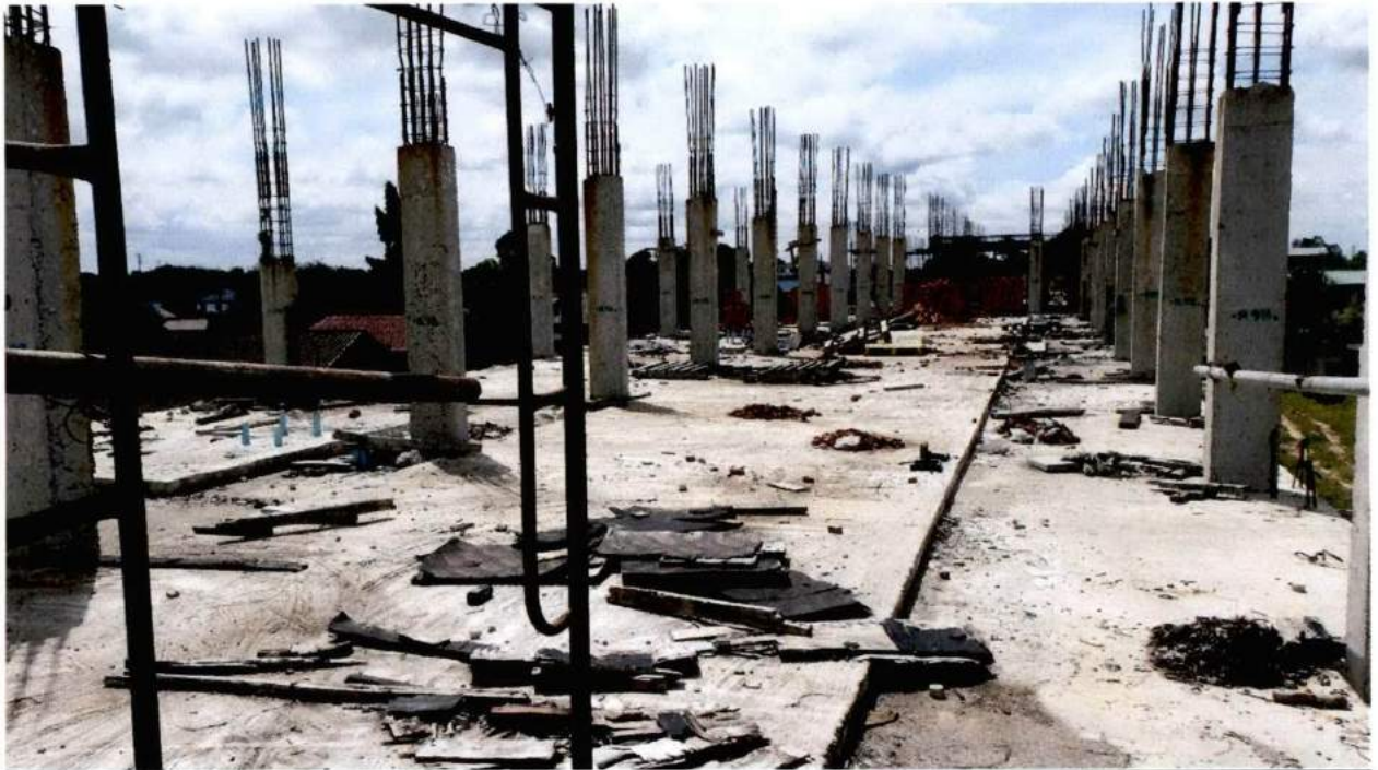
รูปภาพโครงสร้างเสาชั้น 3 อาคาร B
