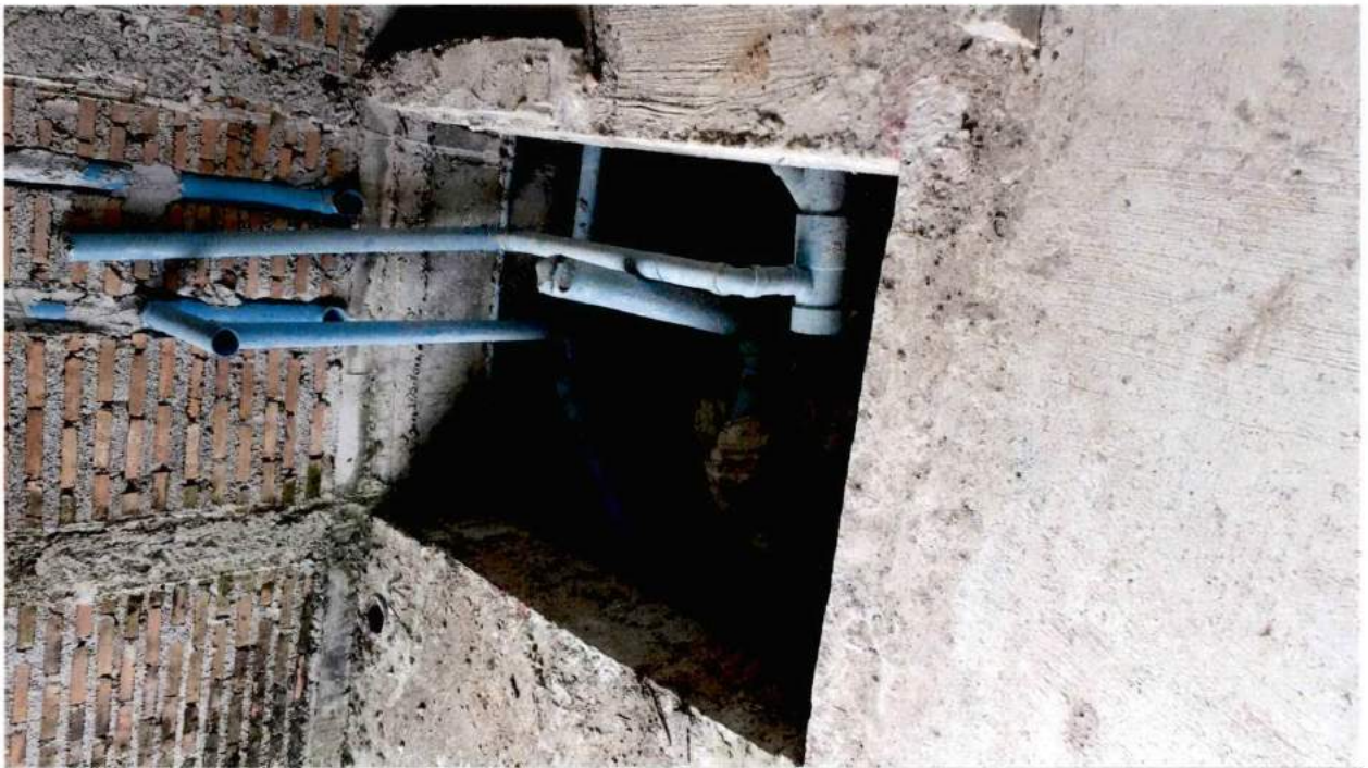
พื้น SP ชั้นล่าง ที่บริเวณห้องน้ำ ชั้น 1 ทุกห้อง อาคาร C
