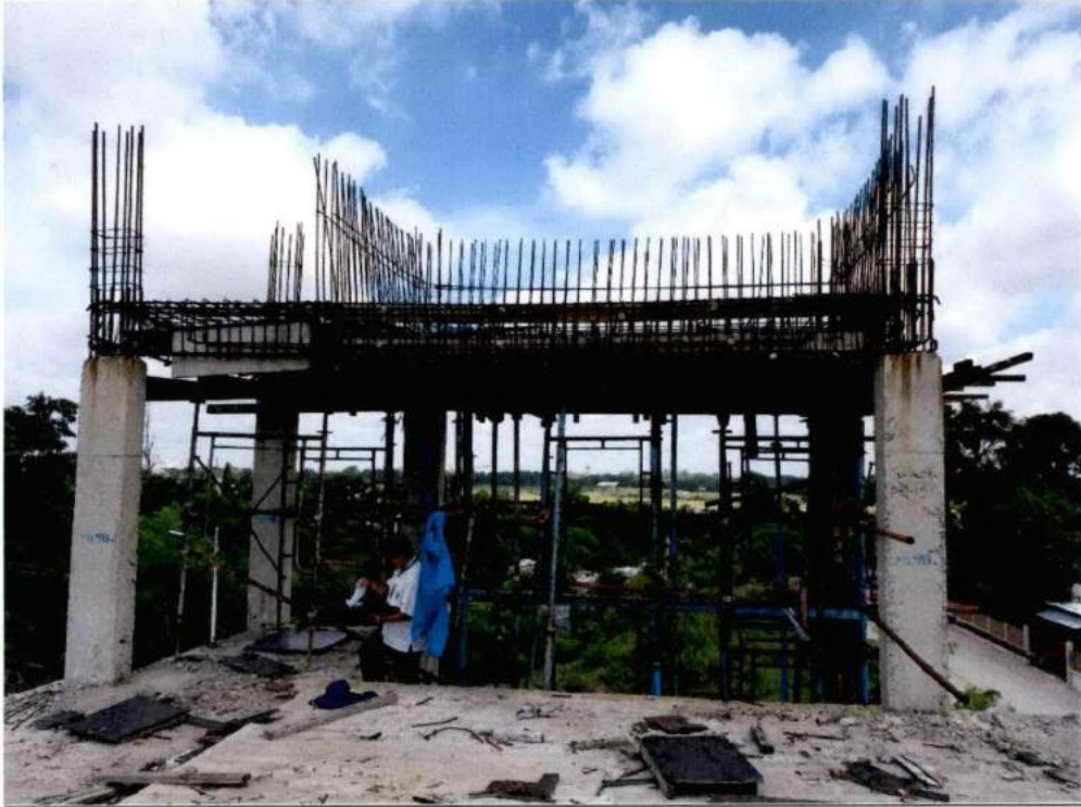
รื้อนั่งร้าน คาน เสา พื้น และเหล็กเสริมออก ส่วนรองรับถังเก็บน้ำทั้งหมด และทำใหม่ ทั้งหมด
