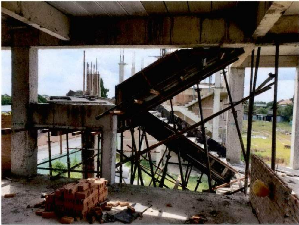
รูปแบบหล่อเหล็ก ที่บันไดทางขึ้น-ลง ทั้ง 2 ด้านของอาคาร A
