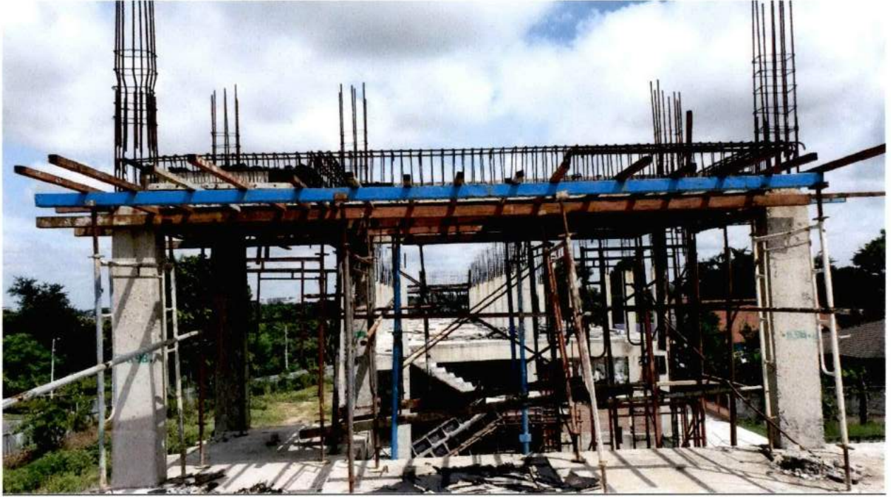
รูปภาพ รีโอแบบหล่อและเหล็กเสริม คาน พื้น เสา ชั้นพื้นที่เก็บน้ำ อาคาร B
