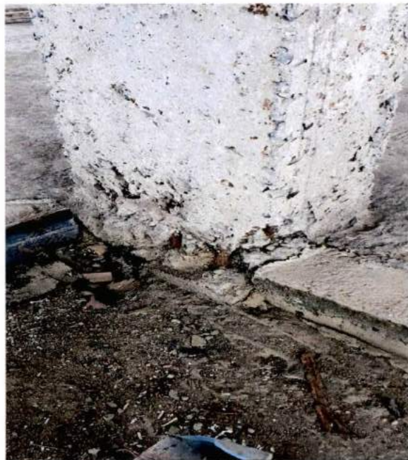
ซ่อมโดนเสา Line HJ-H2 ที่ชั้น 2 อาคาร C โดยใช้ Cement Non Shrink
