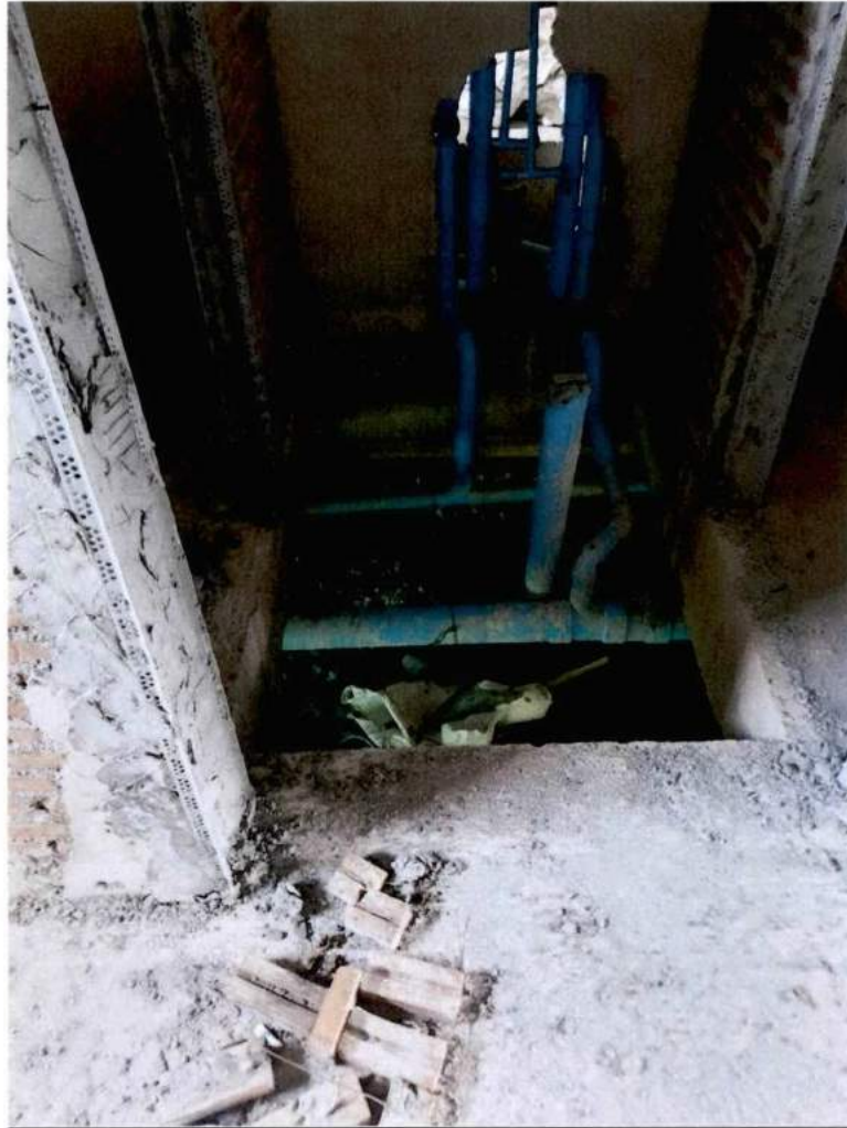
พื้นที่ SP ชั้นล่าง ที่บริเวณห้องน้ำ ชั้น 1 ทุกห้อง อาคาร A
