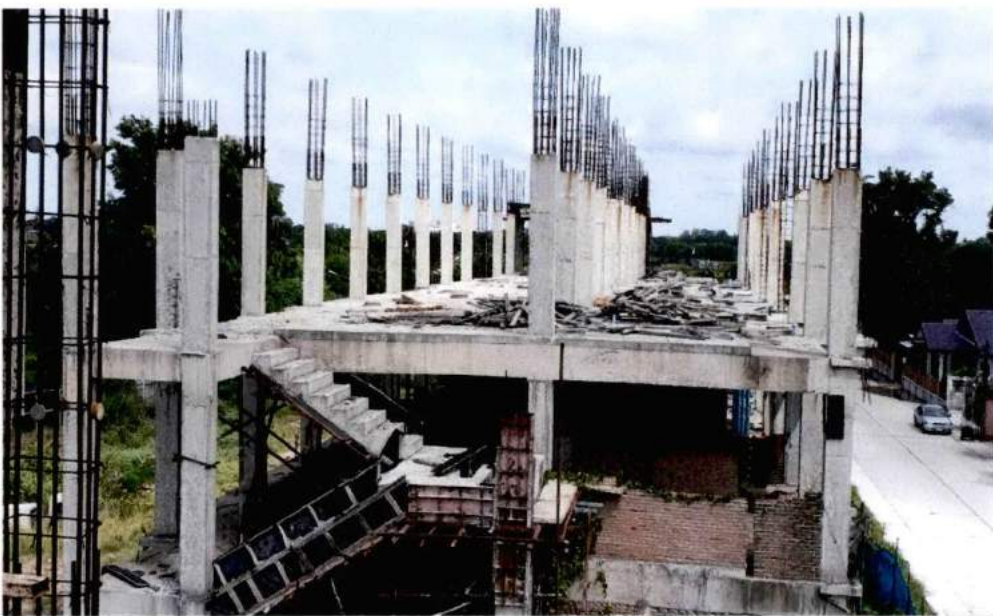
รูปภาพโครงสร้างเสาชั้น 3 และส่วนที่รีบบแบบหล่อโครงสร้างทั้ง 2 ด้าน อาคาร A
