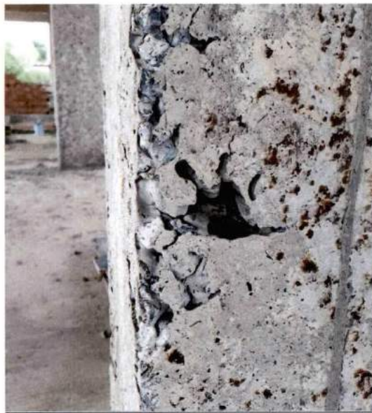
ซ่อมคอนกรีต Line HF-H2 ที่ชั้น 2 อาคาร C โดยใช้ Cement Non Shrink
