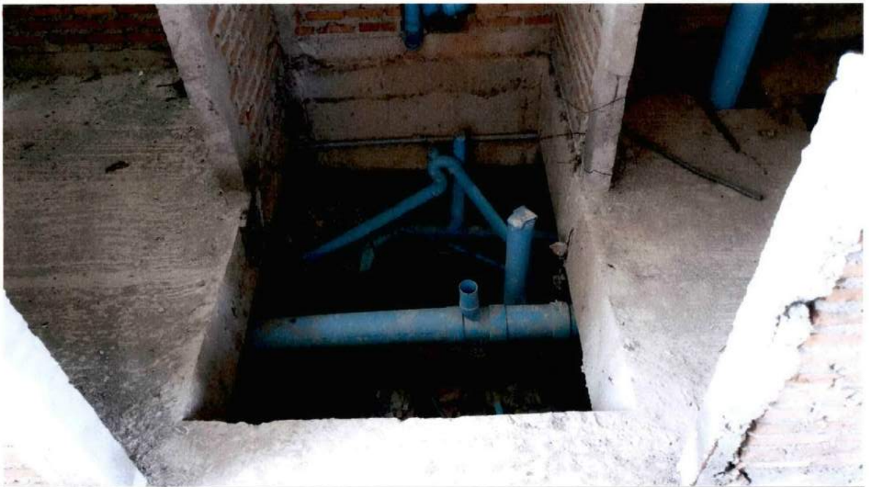
พื้น SP ชั้นล่าง ที่บริเวณห้องน้ำ ชั้น 1 ทุกห้อง อาคาร B
