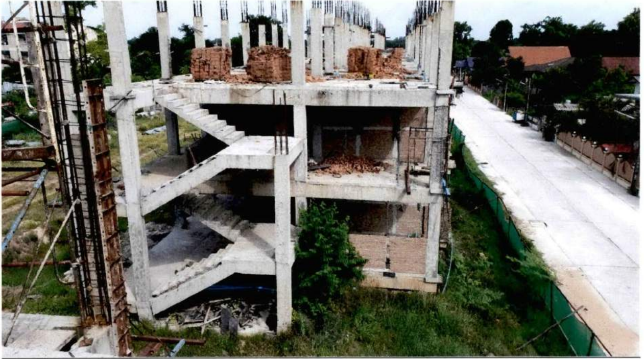
รูปภาพโครงสร้างอาคาร B
