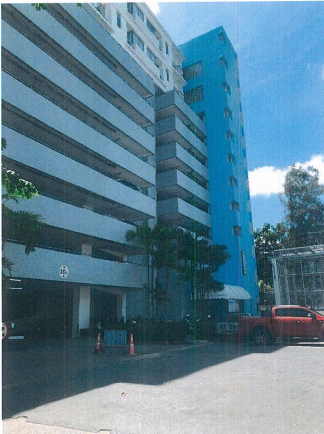
รูปที่ 2 ทางเข้าอาคาร ฝั่งอาคารโรงไฟฟ้า
