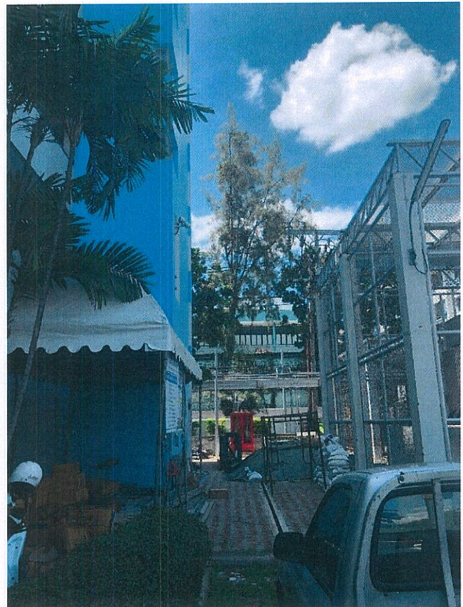
รูปที่ 3 ทางเดินระหว่างอาคาร ติดโรงไฟฟ้า
