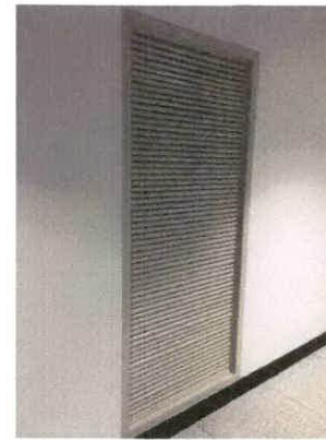
รูปถ่ายประตูระบายอากาศ (ของเดิม) ทางเดินหน้าห้อง
