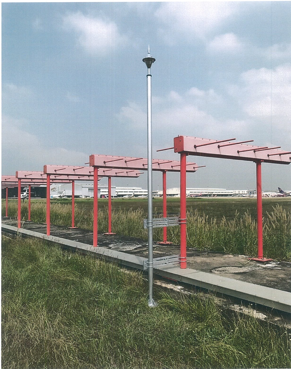
รูปที่ 1 ตัวอย่าง การติดตั้งล่อฟ้าที่บริเวณเสาอากาศสถานี Localizer ล่อฟ้าต้องสูงเหนือตัว เสาอากาศไม่น้อยกว่า 1.5 เมตร
