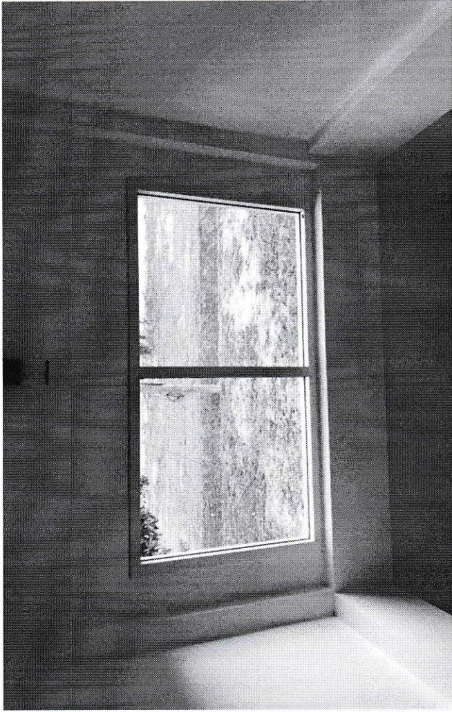
บานหน้าต่างปิดตายโถงบันไดทางขึ้น หน้าต่างเหล็กดัด ขนาด 170 CM x 110 CM
