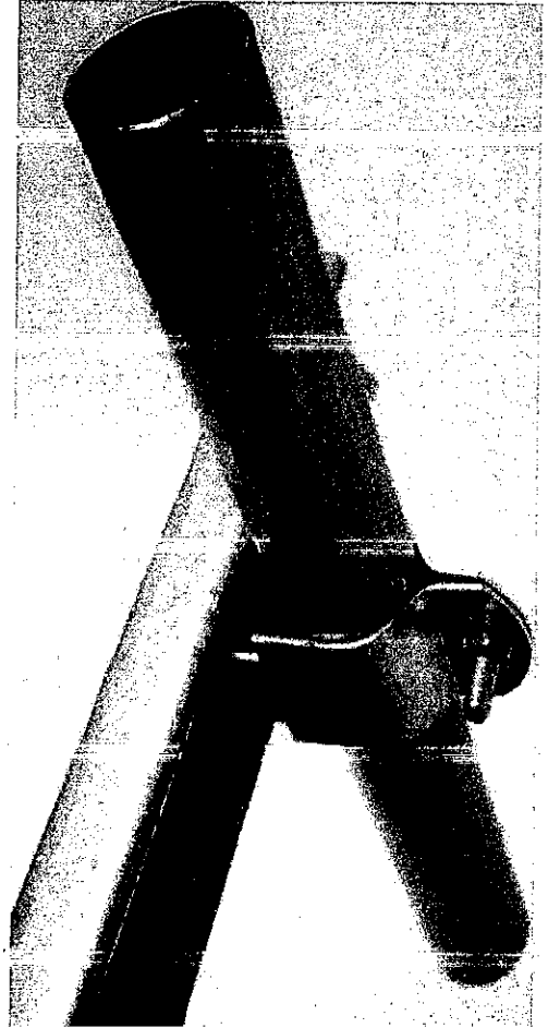
การเดินท่อร้อยสาย EMT (ประกอบ)
